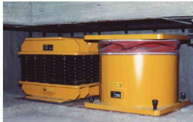
ДЕМПФЕР ООО «ЦВС» В СОЧЕТАНИИ С ПРУЖИНЫМИ БЛОКАМИ
