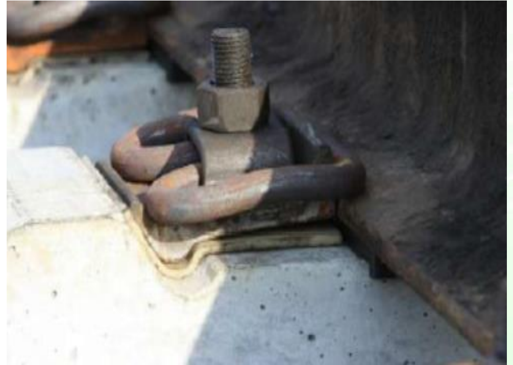
Ш3Нераздельное рельсовое скрепление ЖБР-65
