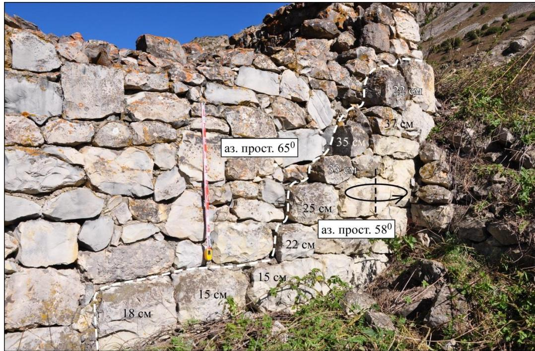
Деформации в углах субширотной стены
