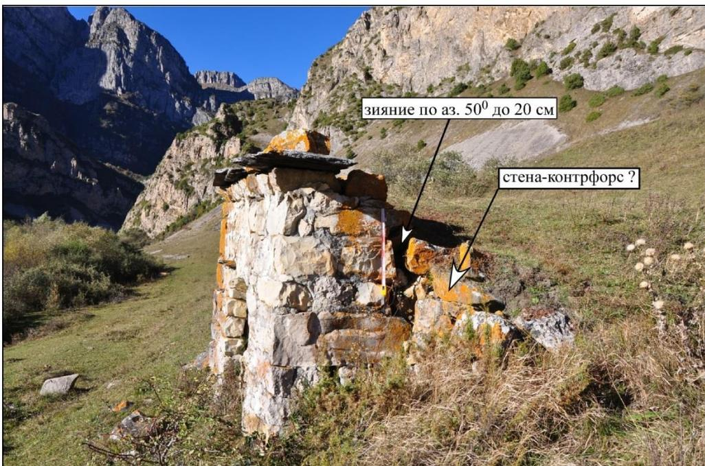
Наклоны и опрокидывание стел в восточном направлении. Деформации железных оградок
