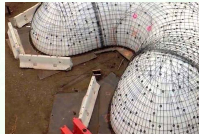
ПРОЦЕСС АРМИРОВАНИЯ ПЕРЕД МОНТАЖОМ КУПОЛА
