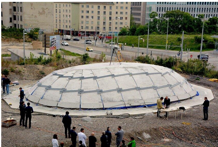
НАДУВНАЯ ОБОЛОЧКА ИЗ БЕТОНА, ВЕНСКИЙ ТЕХНОЛОГИЧЕСКИЙ УНИВЕРСИТЕТ, АВТОРЫ ТЕХНОЛОГИИ: ИОГАНН КОЛЛЕГГЕР, БЕНДЖАМИН КРОМОСЕР
