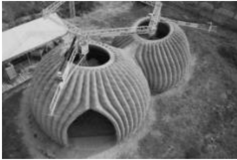
ПЕЧАТЬ ЗДАНИЙ С ПОМОЩЬЮ 3-D ПРИНТЕРА
