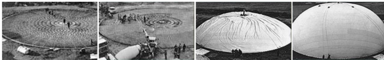
ПРОЦЕСС ВОЗВЕДЕНИЯ ПНЕВМАТИЧЕСКОЙ ОПАЛУБКИ
