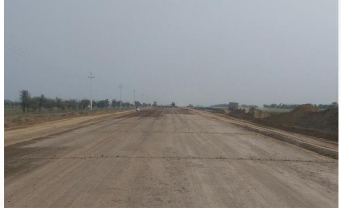
**Предварительная нарезка швов на затвердевшем наноструктурированном шламобетонном слое производится в течение 7-14 суток, на захватке до 3-5 км., для устранения их отражения на асфальтобетонном слое износа.**
