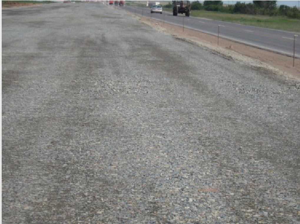
Фото 2007г. Дренирующий щебеночно-песчаный слой снижает вибрацию цементобетонного покрытия на 50%.
