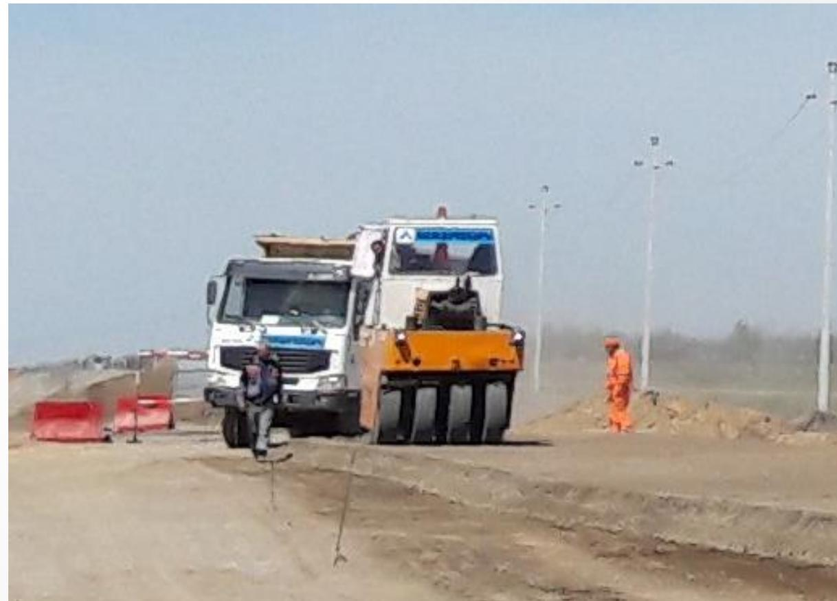
Фото 2016 г. Укладка и уплотнение наноструктурированного шламобетонного нижнего слоя покрытия «Семей – Павлодар».
