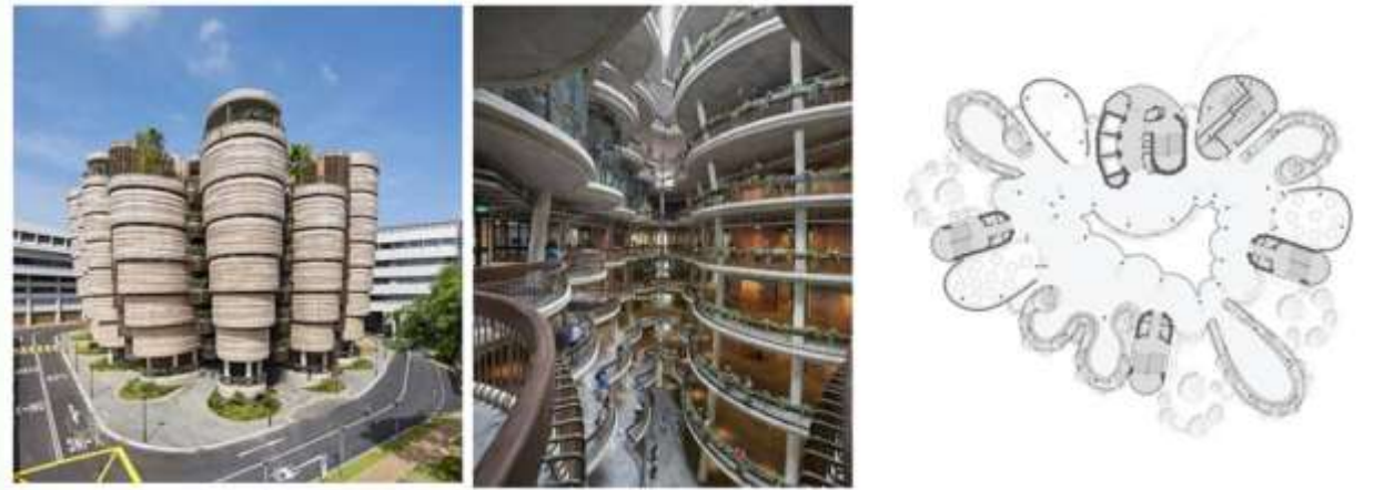
Здание Технологического университета в Сингапуре
