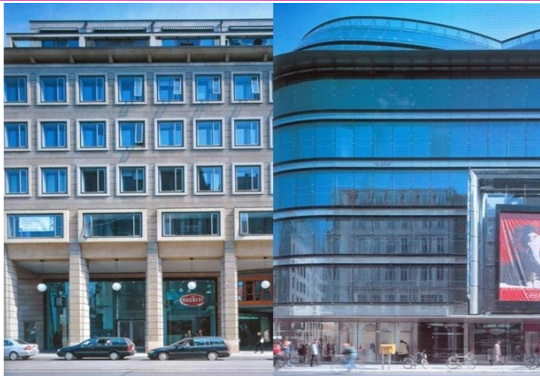
Фасады разных зданий на Фридрихштрассе. Слева Кристоф Мэклер, справа Жан Нувель.
