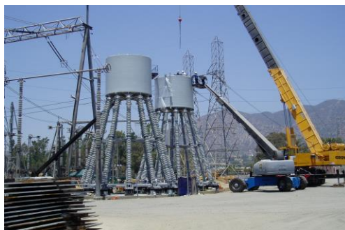
Сейсмоизоляция солнечной электростанции на PGA 1.0 g
