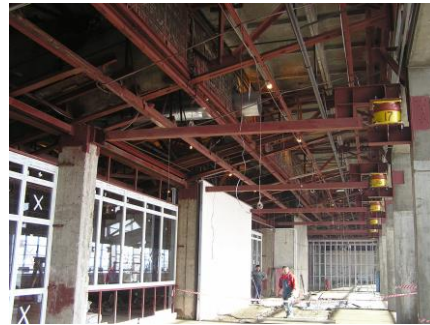
Соединение демпферами ВД двух соседних зданий, имеющих различную массу, собственные частоты и формы вынужденных колебаний
