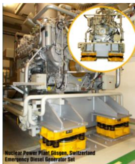
Вибро и сейсмиризация дизель-генератора
