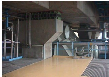
Вибро и сейсмоизоляция мощных турбоагрегатов
