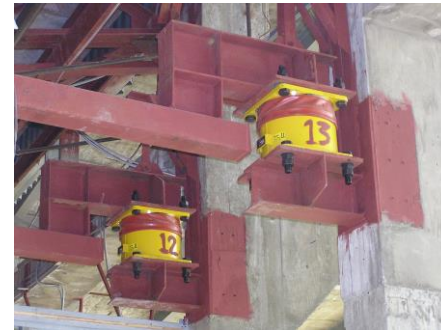
Соединение демпферами ВД двух соседних зданий, имеющих различную массу, собственные частоты и формы вынужденных колебаний
