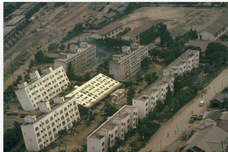
Разжижение грунтов 16 июня, 1964, Ниигата, Япония,
