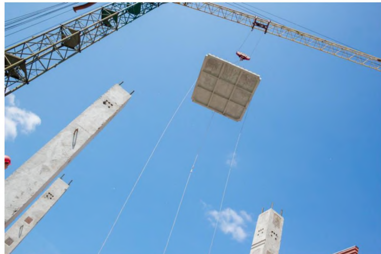
Плита перекрытия для ячейки 4,2 x 4,2 м.
