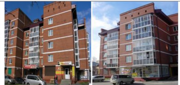
Общий вид жилого дома № 5
